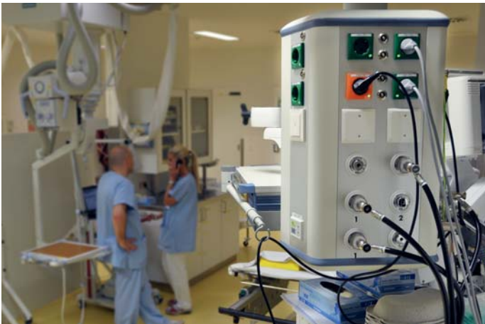
Grüne und rote Steckdosen stehen immer unter Strom
