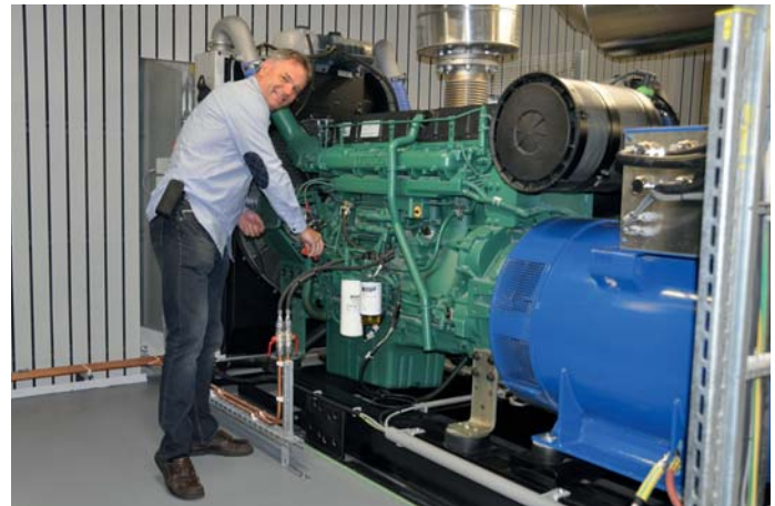
Notstromgeneratoren sorgen für ausfallfreie Geräte im OP
